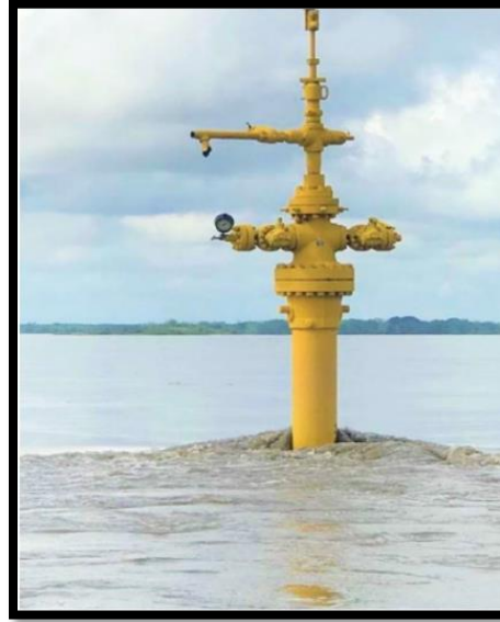
Figura 1. Estado del pozo previo al abandono.
