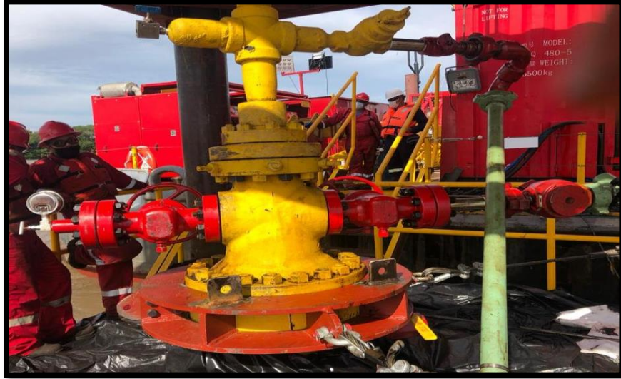
Figura 12. Cabezal asegurado del pozo Bajo Rio 2.
