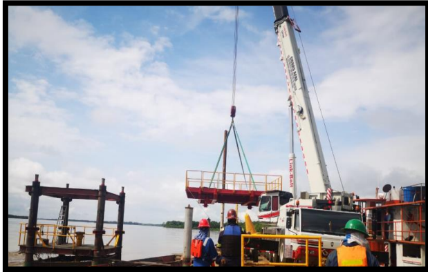
Figura 23. Desmantelamiento de plataforma superior e inferior.
