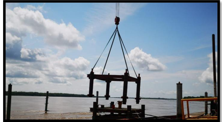
Figura 23. Desmantelamiento de plataforma superior e inferior.
