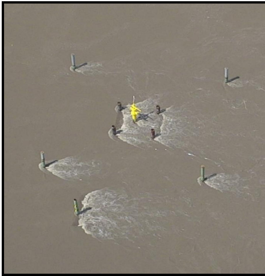
Figura 8. Hincado de 9 pilotes en el lecho del Rio Magdalena.
