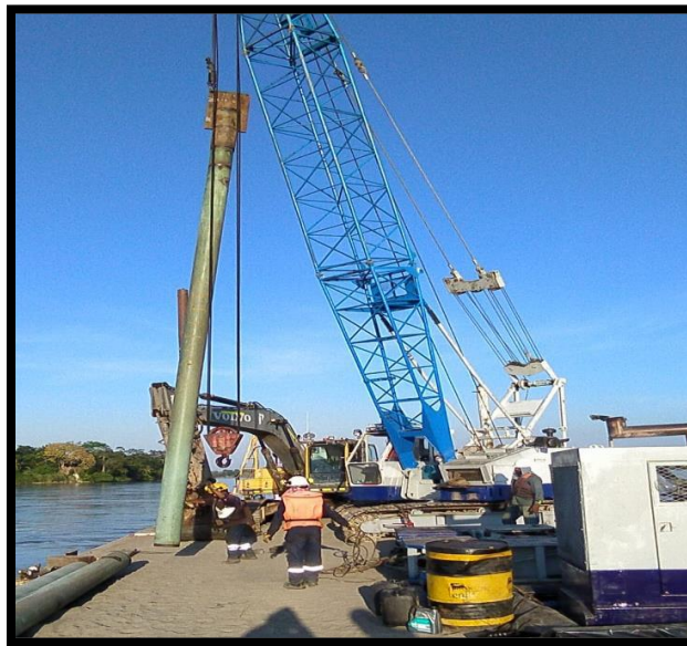
Figura 24. Proceso de extracción de los nueve (9) pilotes.
