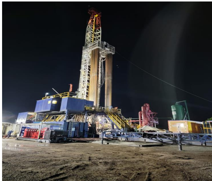
Figura 1. Equipo de perforación GRS 158
