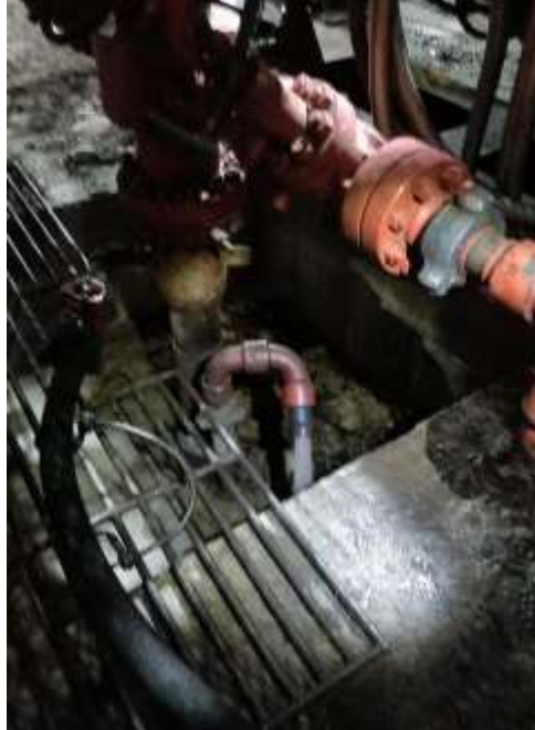
Figura 18. Confirmación Hidráulica por Circulación del Pozo con Retorno en Superficie.
